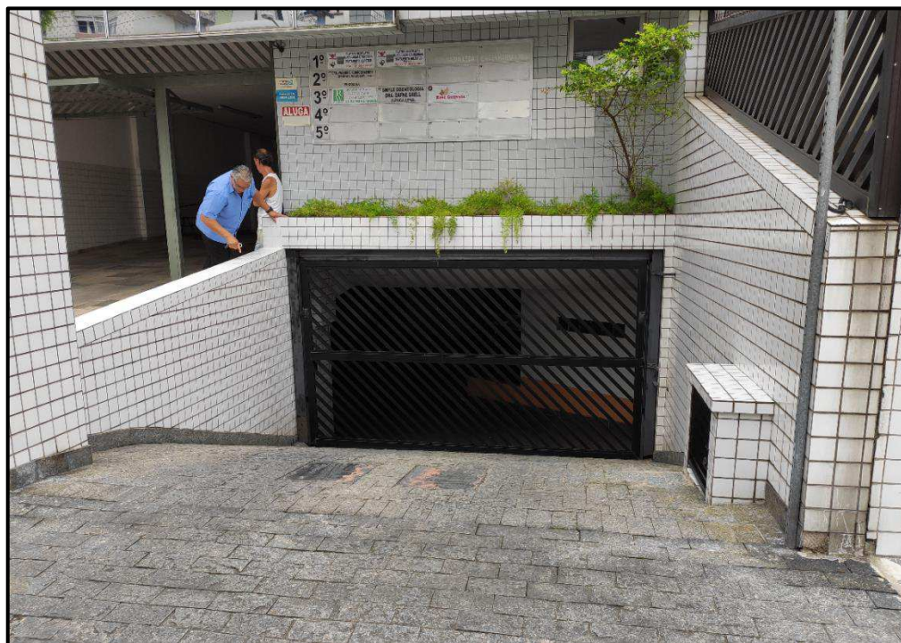
Foto 5: Área Comum – Vista do acesso ao estacionamento no subsolo
