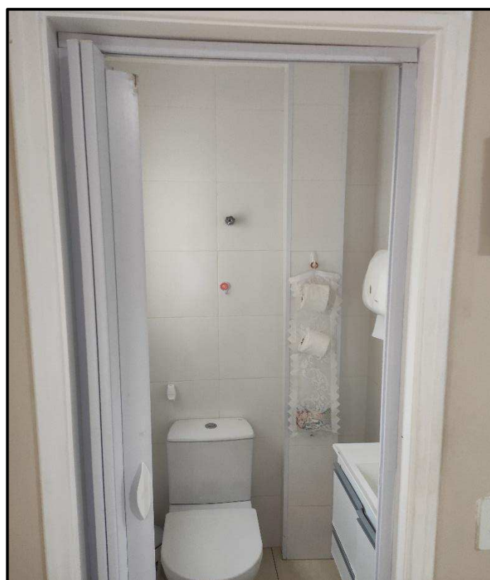
Foto 20: Vista interna do imóvel – Lavabo
