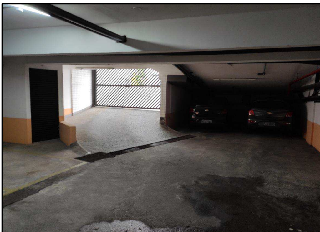
Foto 11: Área Comum – Entrada do estacionamento subsolo
