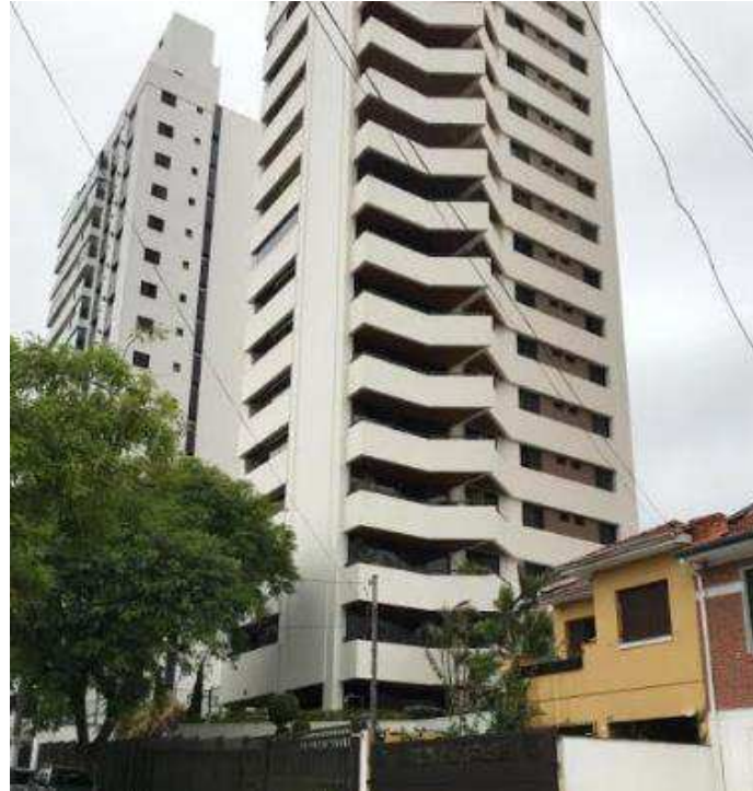
FOTO Nº02 Vista Parcial do Edifício Anacapri – outro ângulo
