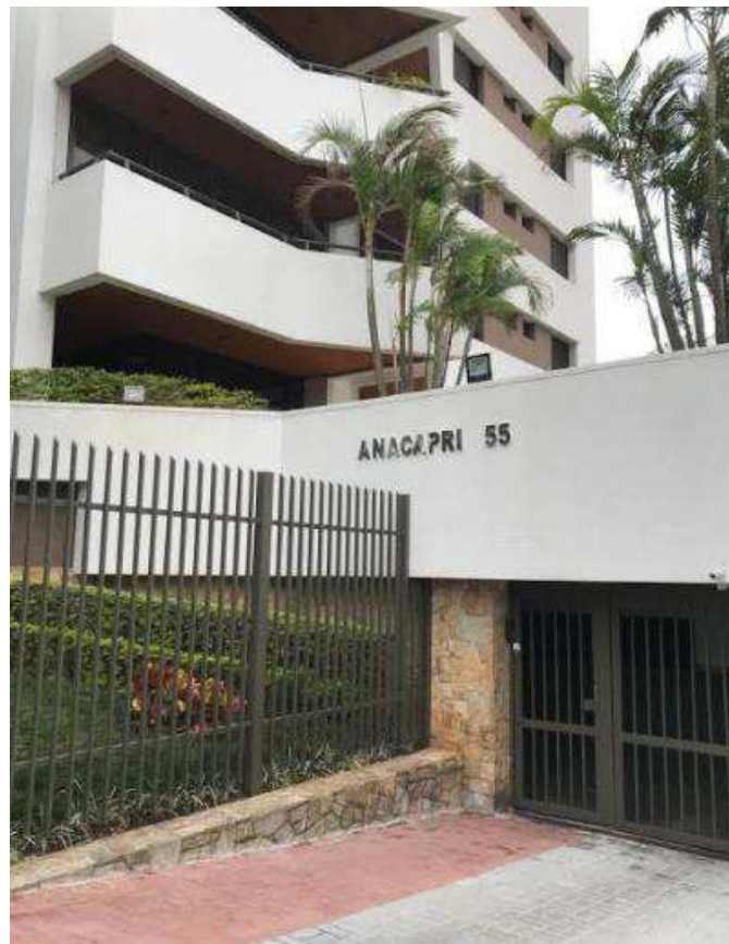
FOTO Nº 01 Vista Parcial da Fachada do Edifício Anacapri
