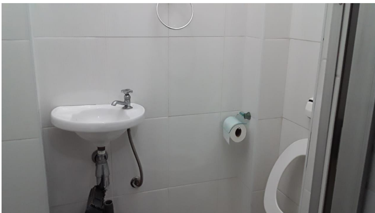
FOTO 09:- Vista do banheiro de serviço do imóvel.
