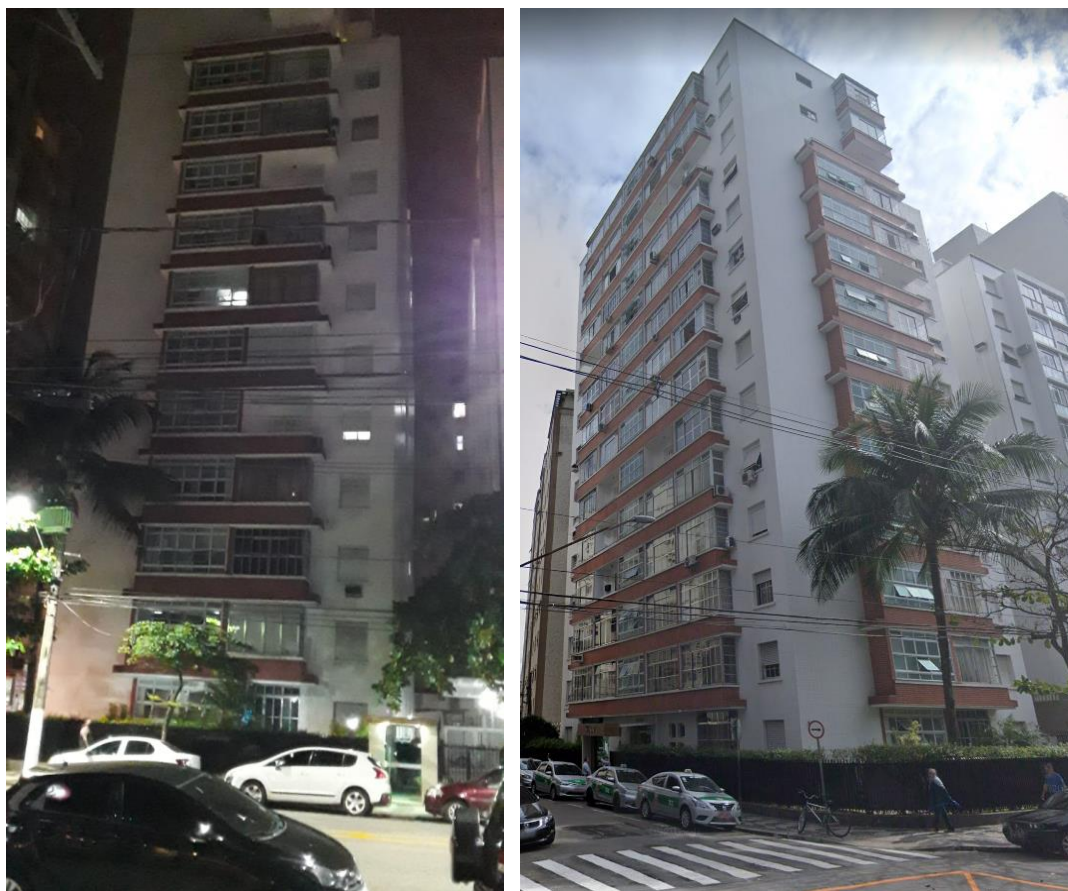
FOTO 01: - Vista da fachada geral do empreendimento.
