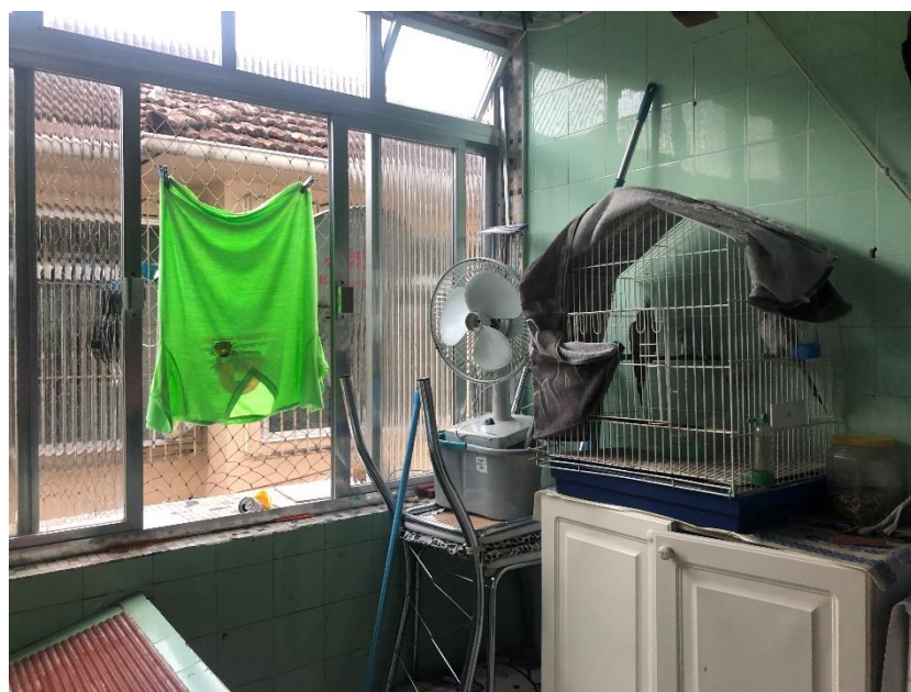
Foto 03 – Vista da cozinha. Suas principais características construtivas são: piso cerâmico, paredes azulejadas até o teto, forro em laje e esquadrias de alumínio.
