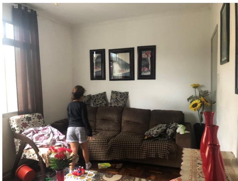
Foto 04 – Vista da sala. Suas principais características construtivas são: piso cerâmico, paredes revestidas em massa corrida pintadas em látex, forro em laje e esquadrias de alumínio.
