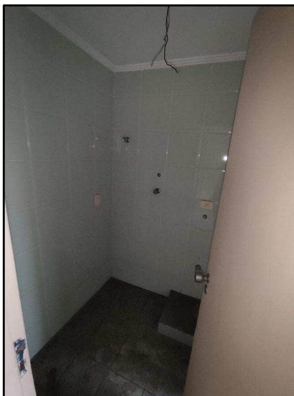
Foto 22: Vista interna do imóvel – Banheiro/lavatório
