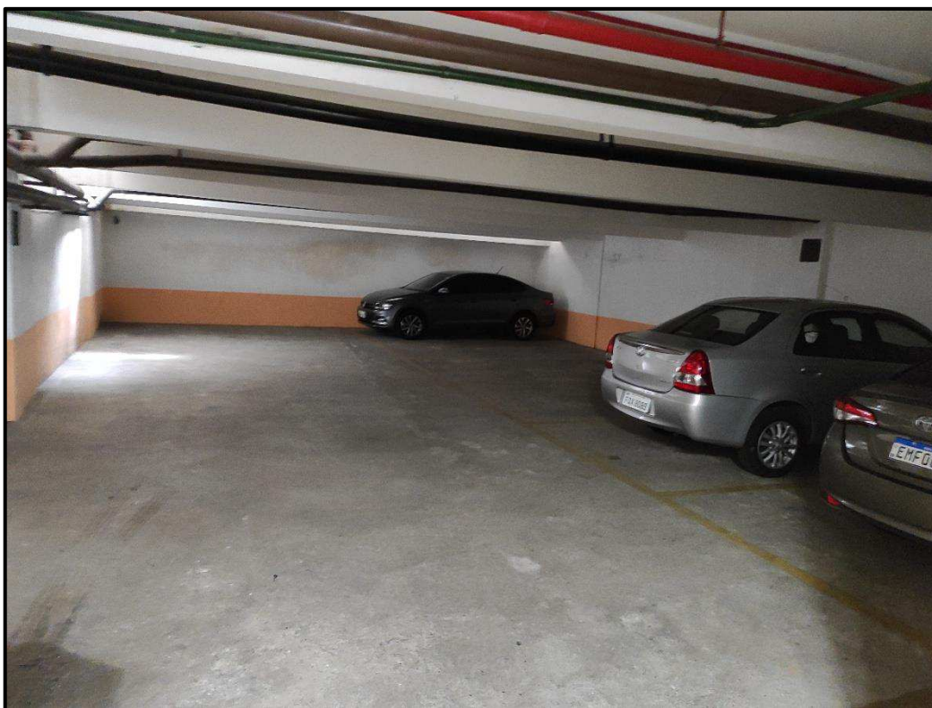
Foto 10: Área Comum – Estacionamento subsolo
