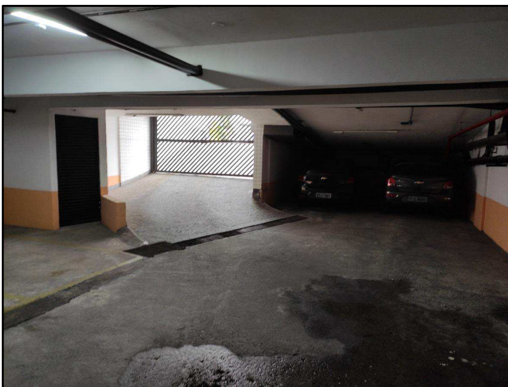
Foto 11: Área Comum – Entrada do estacionamento subsolo
