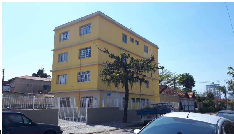
FOTO 1 (Anexo IV) – Fachada do Edifício Vate Real.
