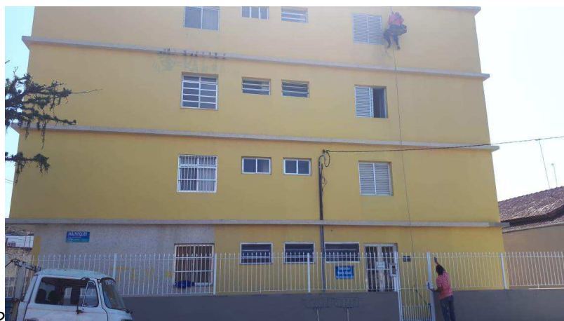
FOTO 2 (Anexo IV) – Entrada principal pela Rua Malmequer nº 536
