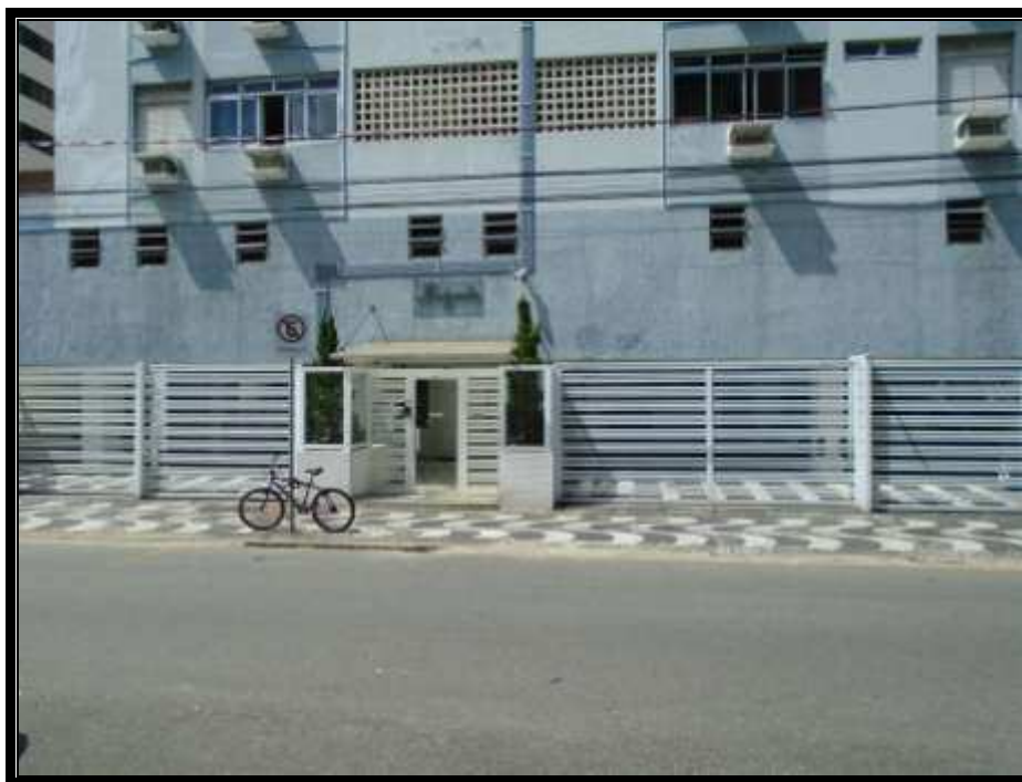
Vista parcial da entrada do Edifício Kalumba
