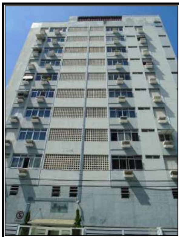
Vista parcial da fachada do Edifício Kalumba.
