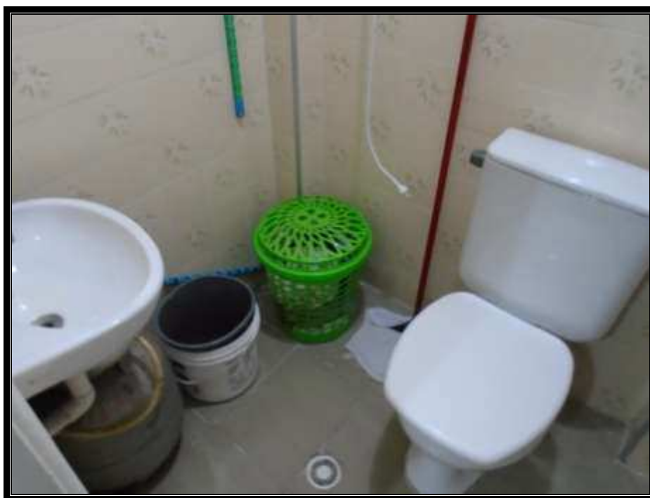
Vista parcial do wc.
