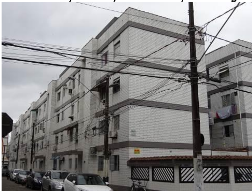
FOTO 1: Vista da fachada frontal do edifício Paraguai.
