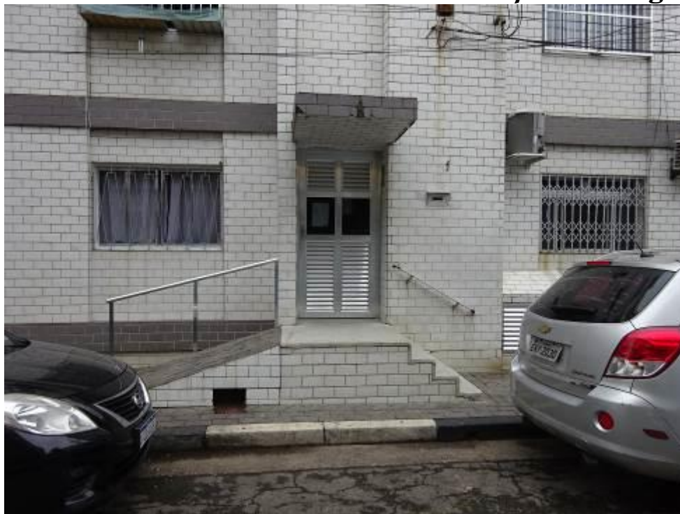
FOTO 3: Vista da entrada de acesso ao edifício Paraguai.
