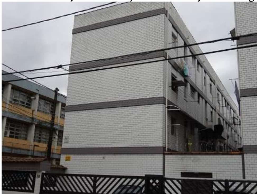
FOTO 2: Vista da fachada de fundos do edifício Paraguai.
