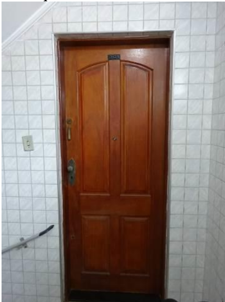
FOTO 6: Vista da porta de entrada do imóvel avaliando.
