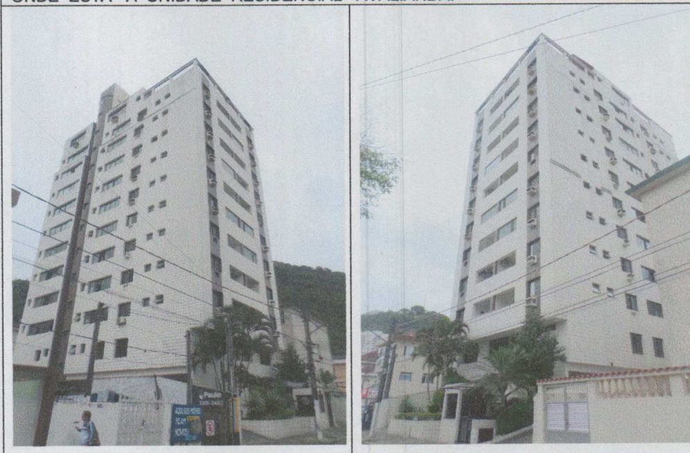
FOTO-SÉRIE 02 - ENFOQUES DE FACHADAS DO EDIFÍCIO PARQUE SUIÇO, ONDE ESTÁ A UNIDADE RESIDENCIAL AVALIANDA.
