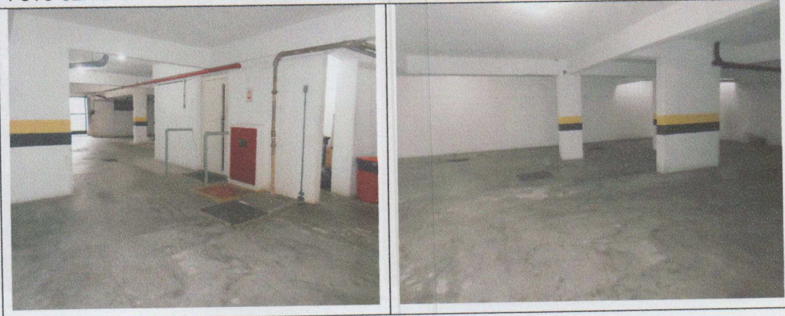
FOTO-SÉRIE 07 - ENFOQUES DA GARAGEM DO SUBSOLO.
