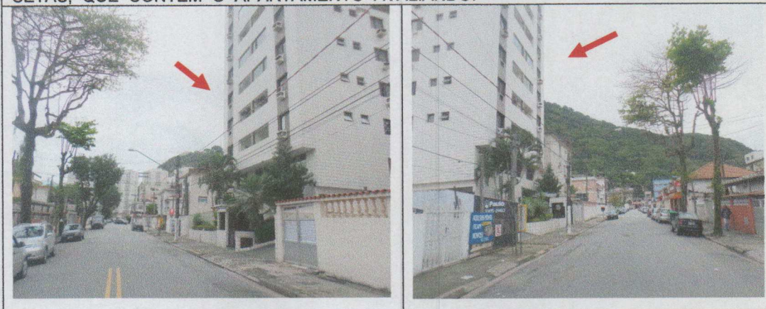
FOTO-SÉRIE 01 - ASPECTO GERAL DA RUA ALBERTO DA VEIGA, VISTA SOB DIFERENTES ÂNGULOS, FOCALIZANDO O EDIFÍCIO PARQUE SUIÇO, INDICADO POR SETAS, QUE CONTÉM O APARTAMENTO AVALIANDO.
