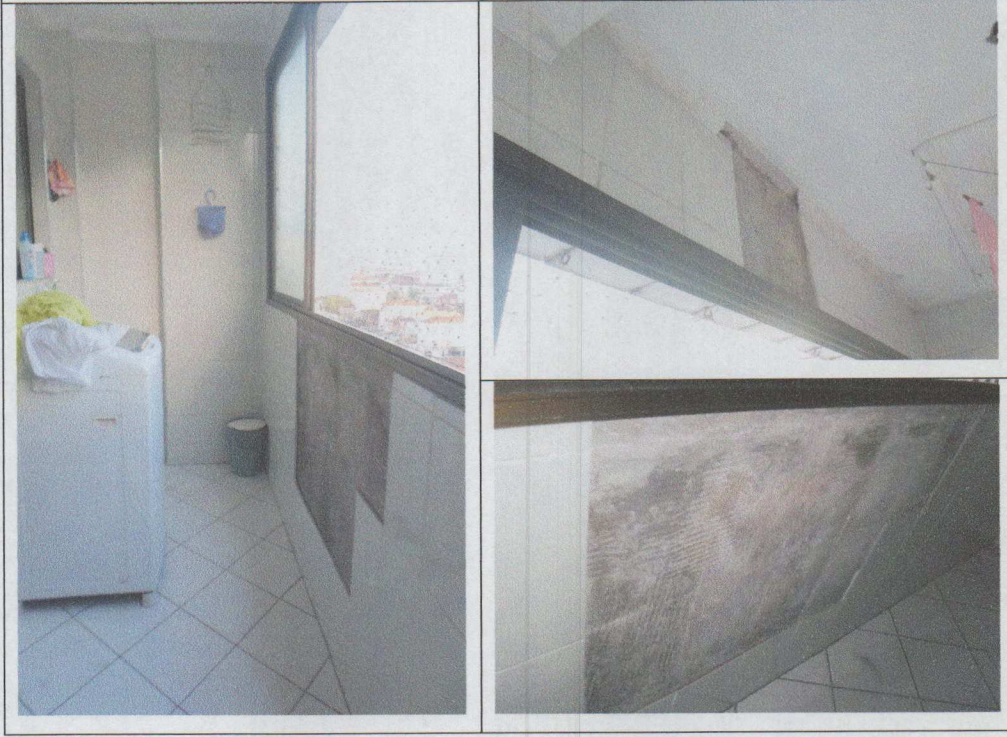
FOTO-SÉRIE 15 - REGISTROS DA ÁREA DE SERVIÇO, FOCALIZANDO O DESTACAMENTO LOCALIZADO DE PEÇAS CERÂMICAS NA PAREDE EXTERNA.
