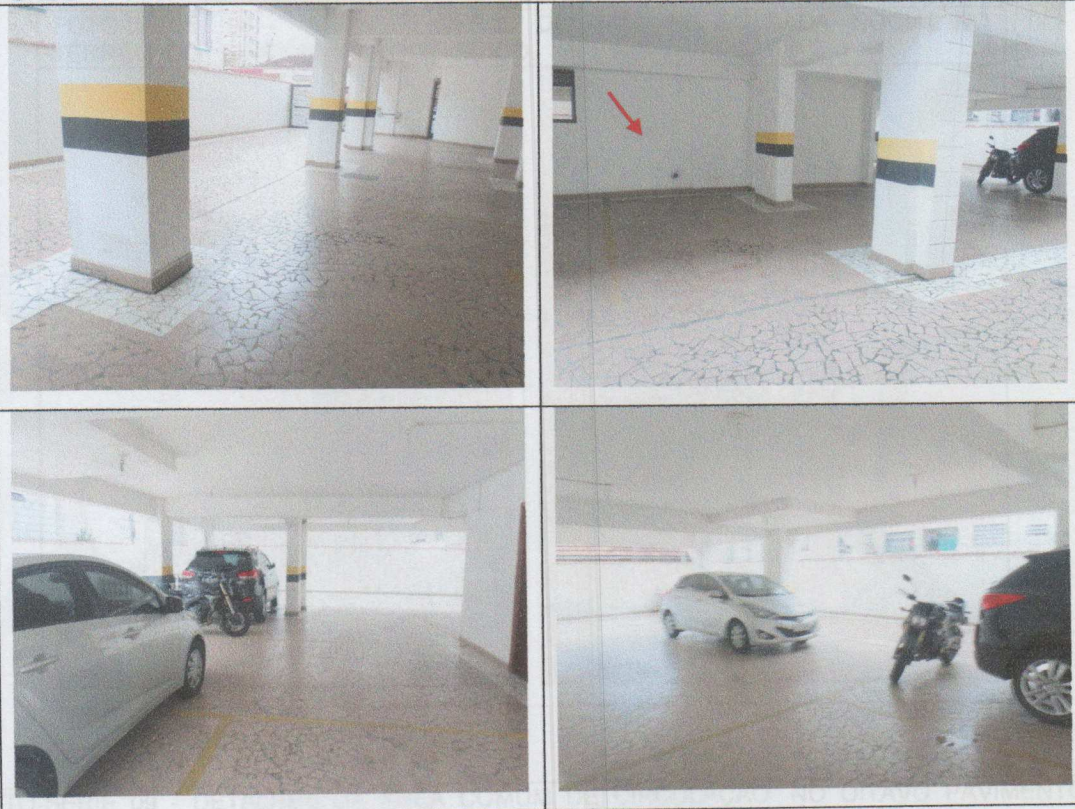
FOTO-SÉRIE 06 - REGISTROS DA GARAGEM TÉRREA, COM VAGAS DEMARCADAS, ONDE A SETA INDICA A VAGA ATRIBUÍDA À UNIDADE AVALIANDA DE Nº 82
