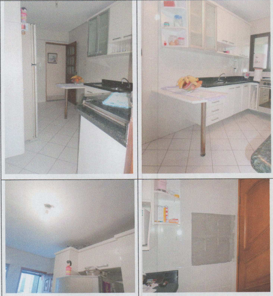
FOTO-SÉRIE 14 - ENFOQUES DA COZINHA, VISTA SOB DIFERENTES ÂNGULOS, MOSTRANDO, NO DETALHE, O DESTACAMENTO DE AZULEJOS.
