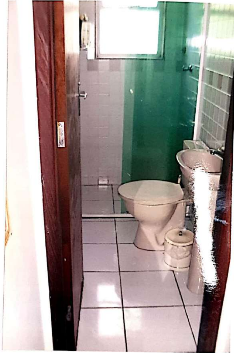
foto nº 13- banheiro da suíte com piso e paredes de cerâmica e louça sanitária de padrão comercial, box blindex
