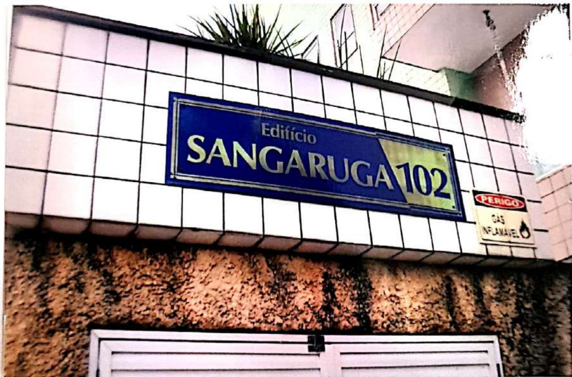
Foto nº 4 - Detalhe da fachada do Condomínio
