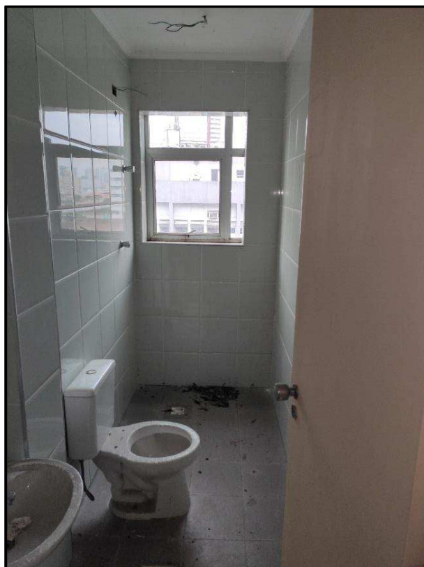
Foto 20: Vista interna do imóvel – Banheiro do andar inferior (5º pavimento)
