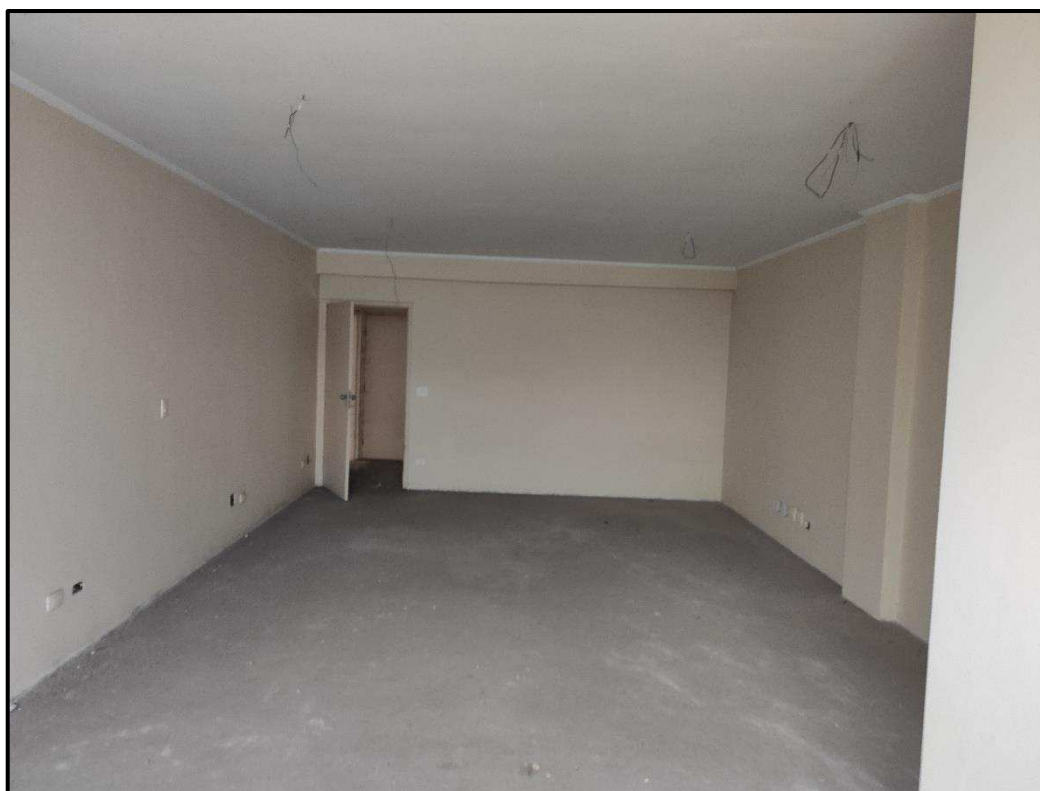
Foto 21: Vista interna do imóvel - andar inferior (5º pavimento)
