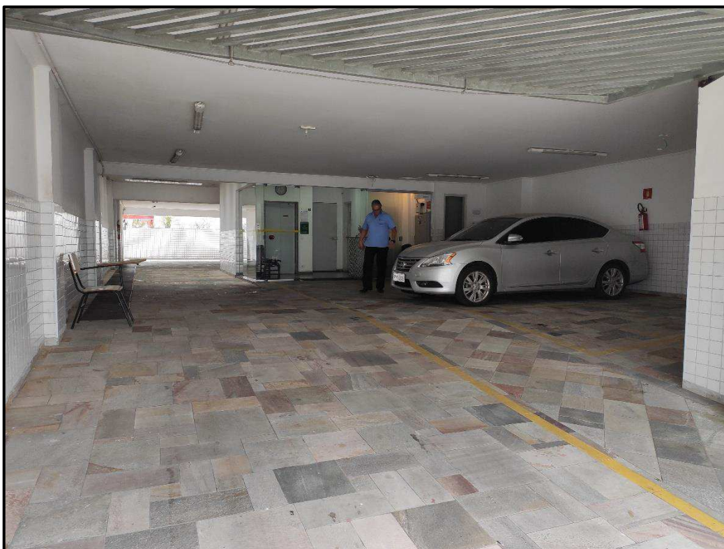
Foto 6: Área Comum – Vista do acesso ao estacionamento do térreo
