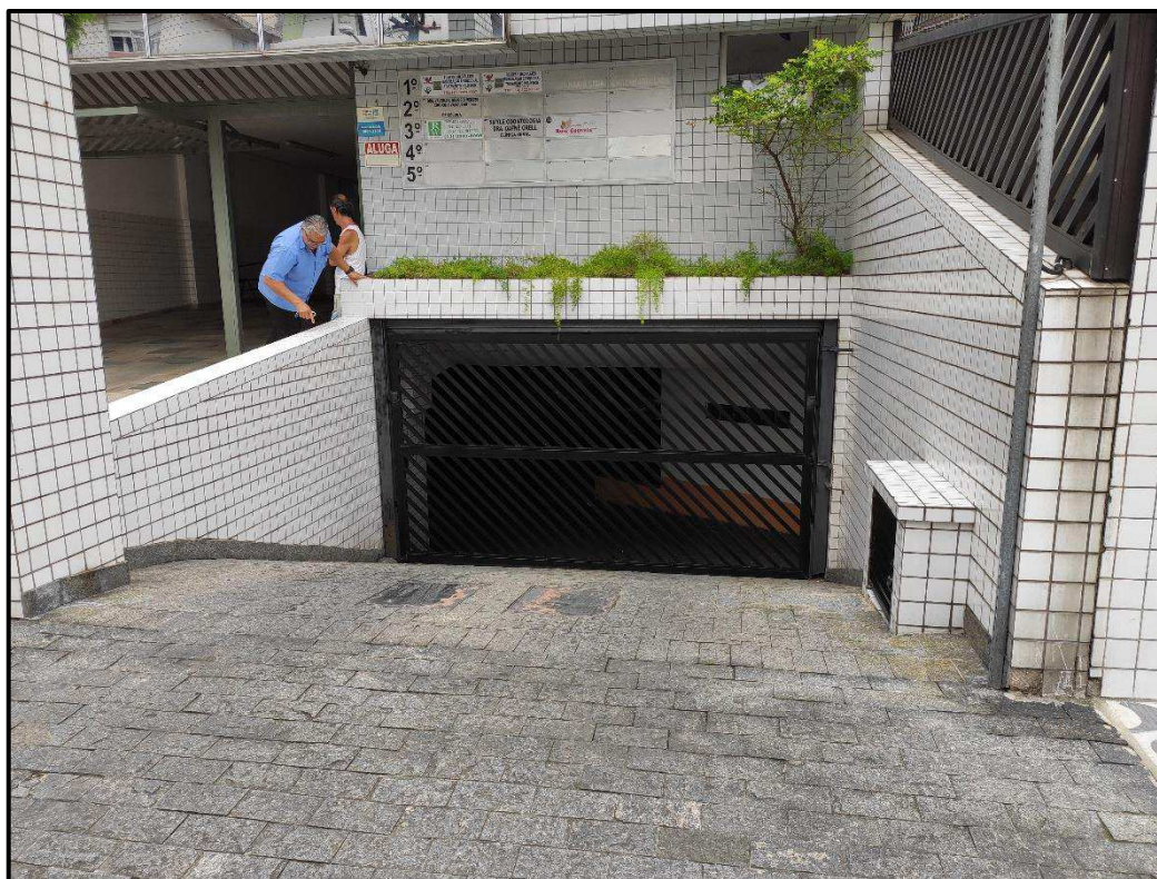
Foto 5: Área Comum – Vista do acesso ao estacionamento no subsolo
