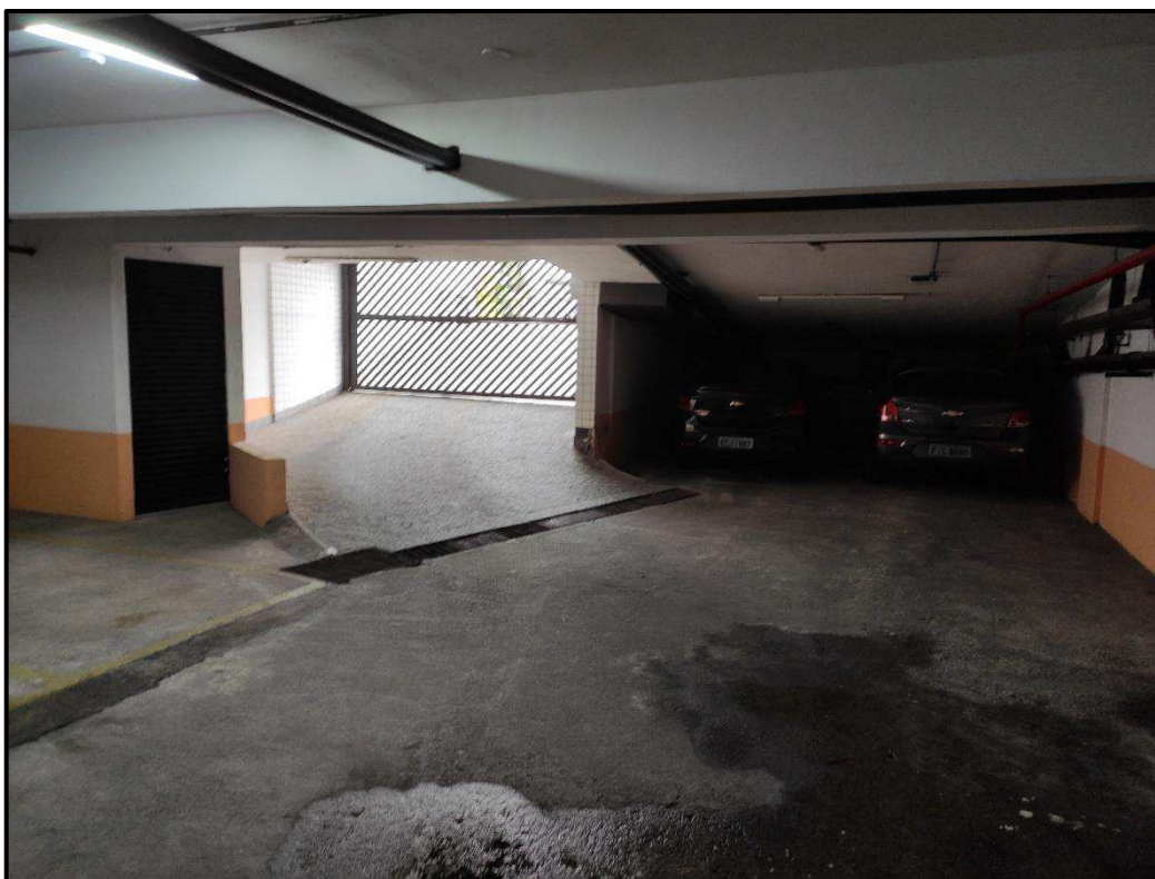
Foto 11: Área Comum – Entrada do estacionamento subsolo
