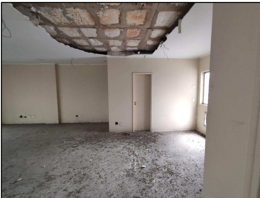
Foto 24: Vista interna do imóvel – Sala do piso superior (6º pavimento)
