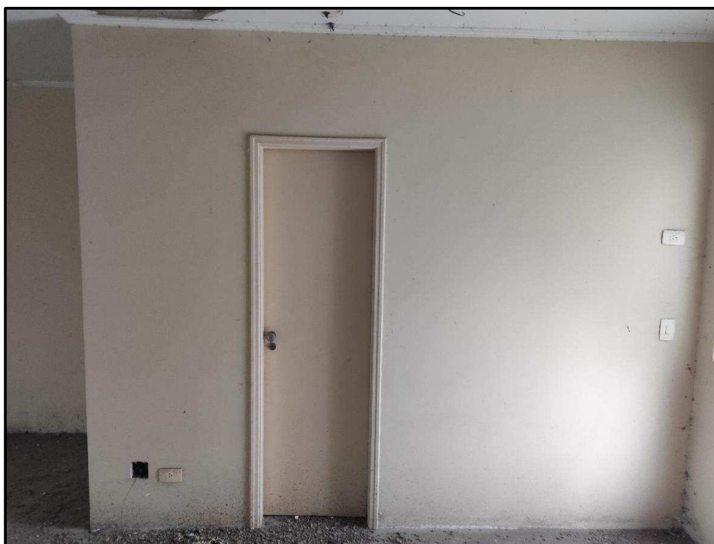
Foto 25: Vista interna do imóvel – Banheiro do piso superior (6º pavimento)
