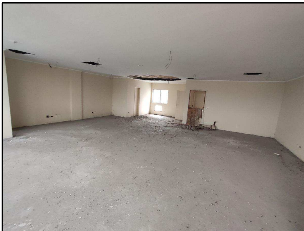
Foto 27: Vista interna do imóvel – Sala do piso superior (6º pavimento)
