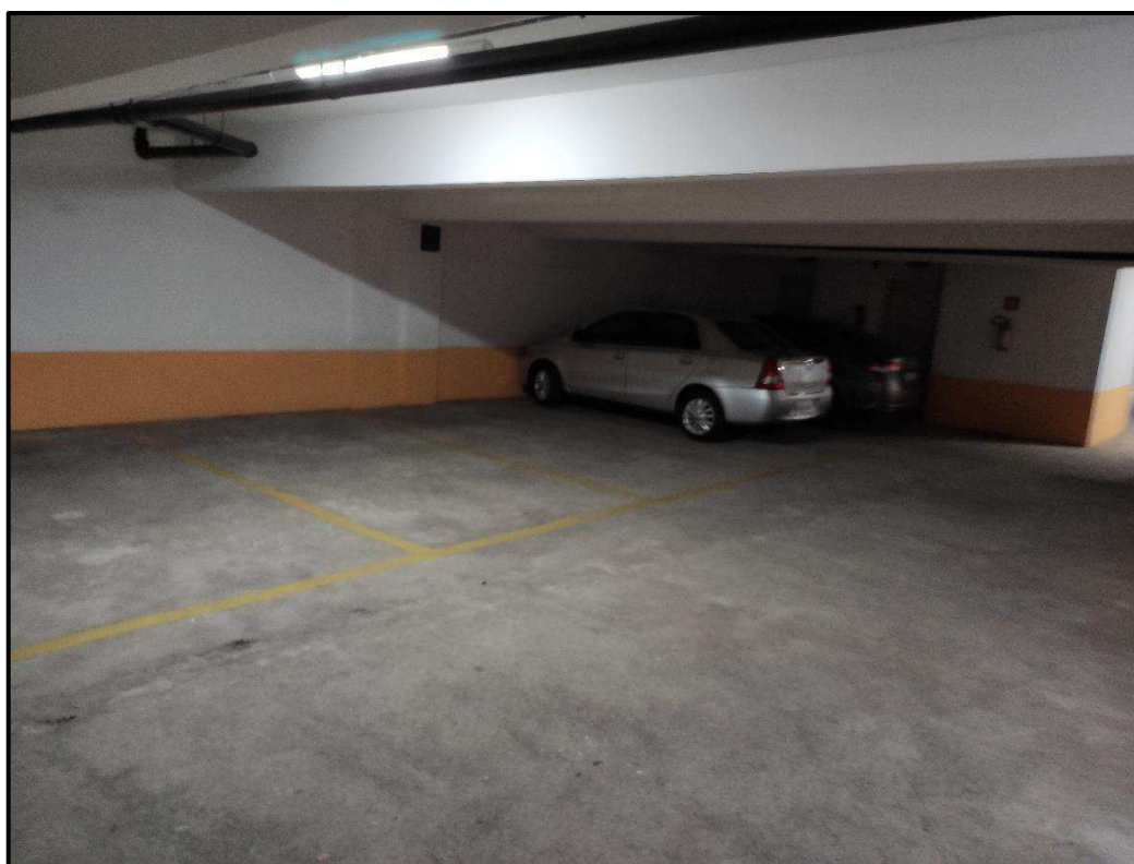
Foto 9: Área Comum – Estacionamento subsolo
