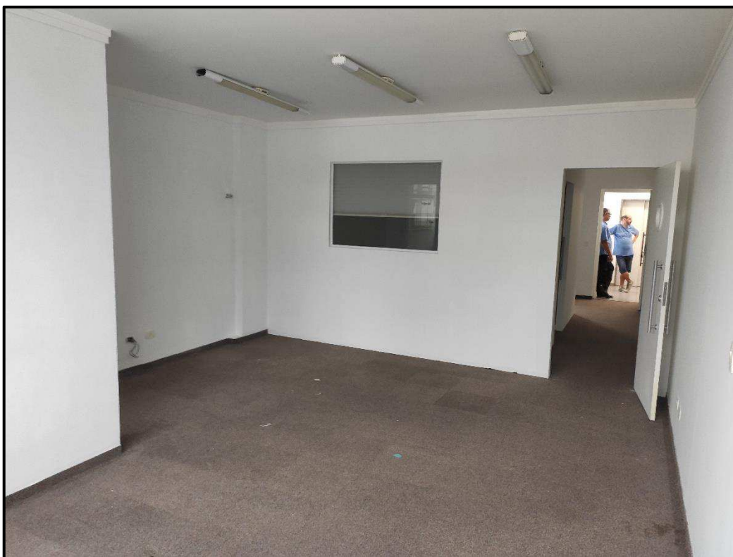
Foto 23: Vista interna do imóvel – Sala 2
