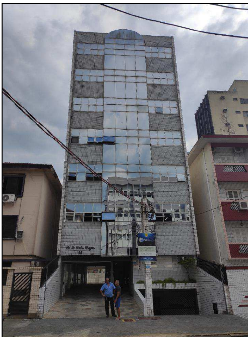
Foto 1: Edifício Carlos Chagas, Rua Monsenhor de Paula Rodrigues, 92, Vila Belmiro, Município de Santos - SP.
