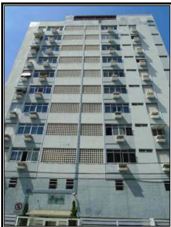
Vista parcial da fachada do Edifício Kalumba.
