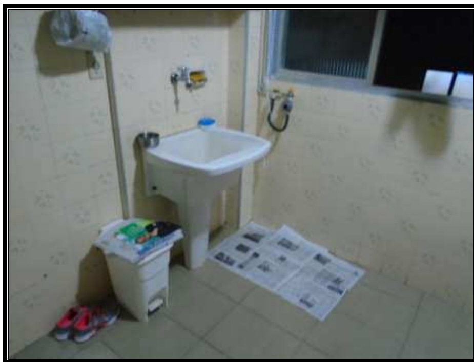
Vista parcial da área de serviço.
