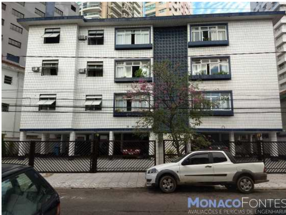
Acima, temos uma tomada da testada do Condomínio Edifício Inhambú.
