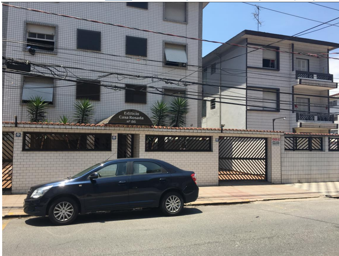
Figura 1 Frente do condomínio
