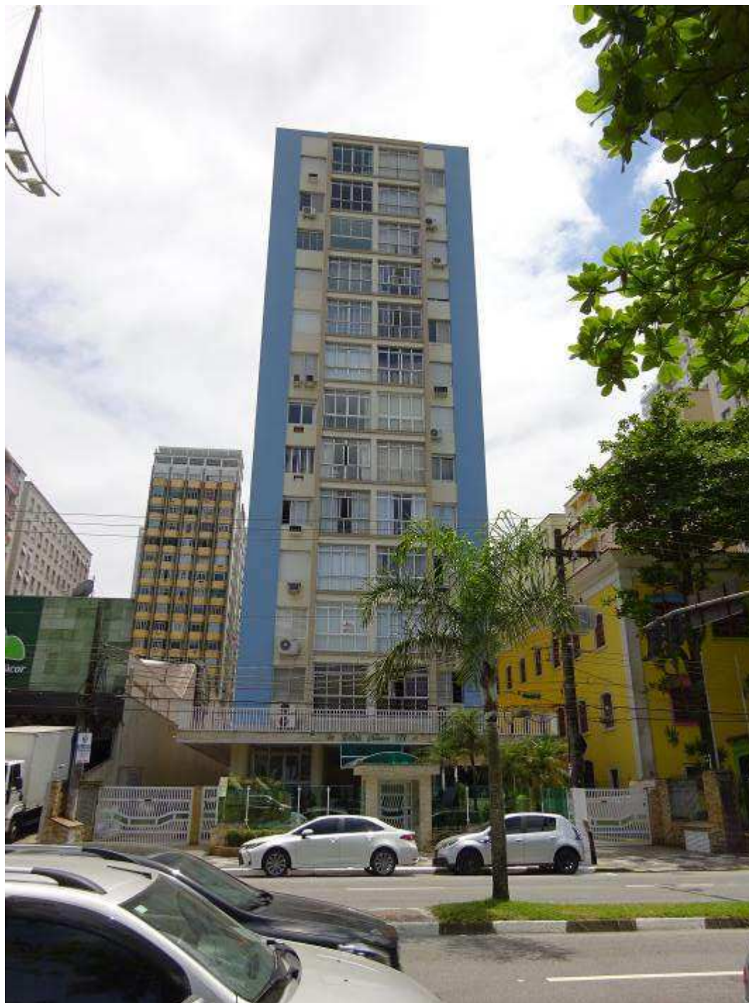
FOTO 1: Vista da fachada frontal do edifício Nossa Senhora de Lourdes.
