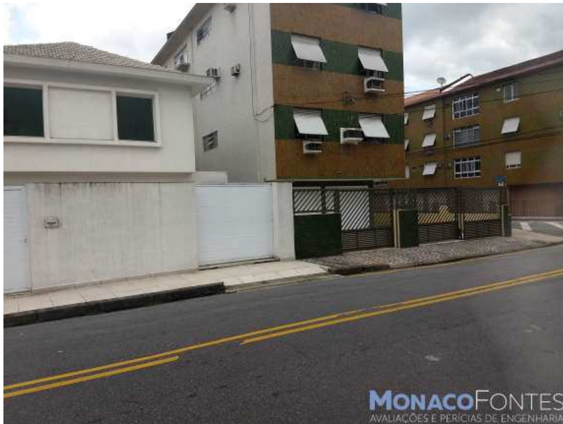
Na imagem acima, tem-se uma demonstração da fachada do imóvel para a Rua São José, onde nota-se as suas características de acesso e topografia.
