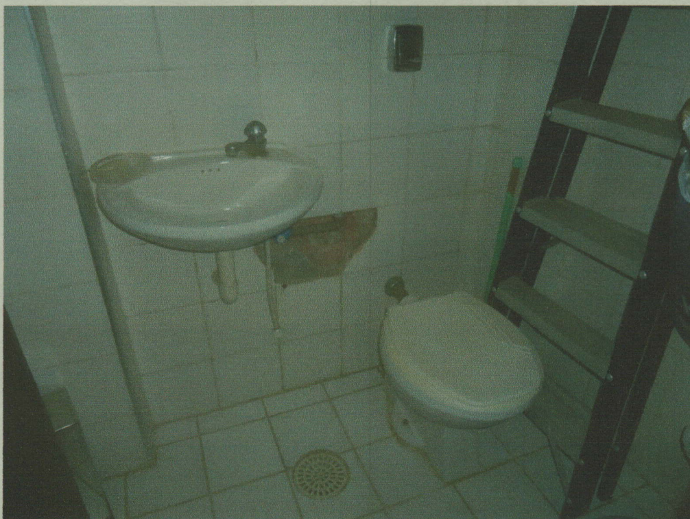
FOTO 07:- Vista do banheiro de serviço do imóvel.
