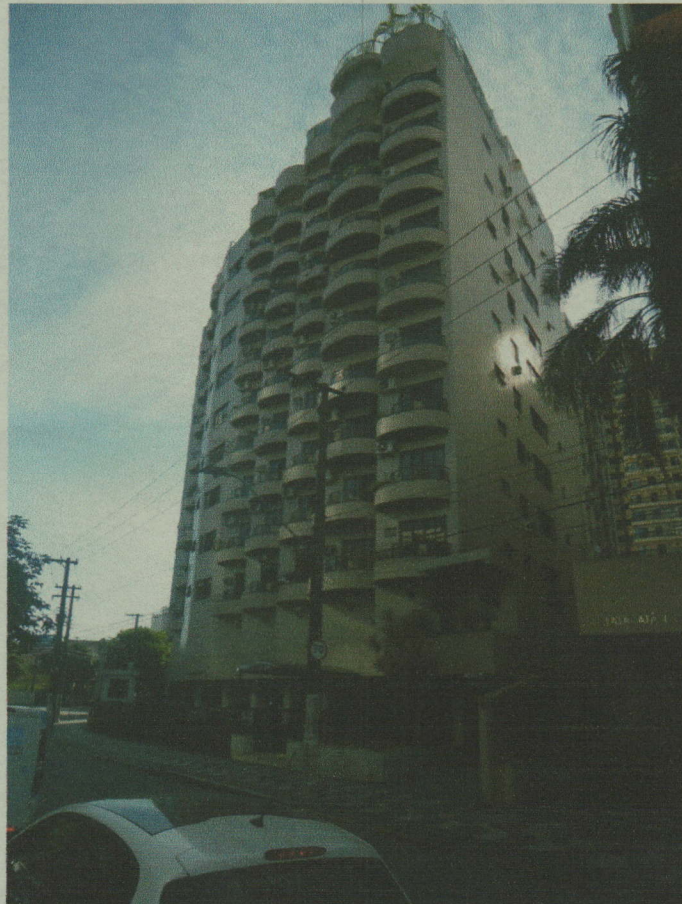
FOTO 02 : - Vista do prédio.
