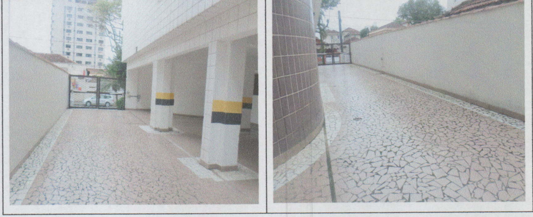
FOTO-SÉRIE 05 - ENFOQUE DE RECUOS PREDIAIS DO EDIFÍCIO PARQUE SUIÇO, COM PISO REVESTIDO POR CACO CERÂMICO.
