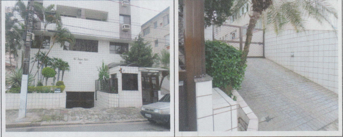
FOTO-SÉRIE 04 - VISTA DA ENTRADA SOCIAL E RAMPAS DE ACESSO ÀS GARAGENS.
