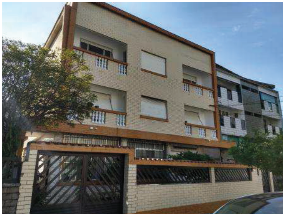
FOTO 2: Fachada do imóvel.
