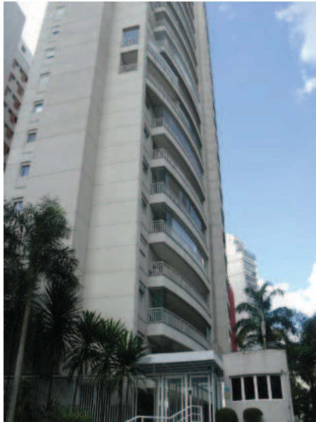
Foto 01 – Frente do imóvel avaliando, Rua Maria Figueiredo, nº 527
