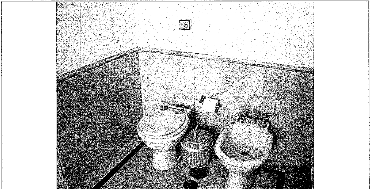
Outra Vista do Banheiro
