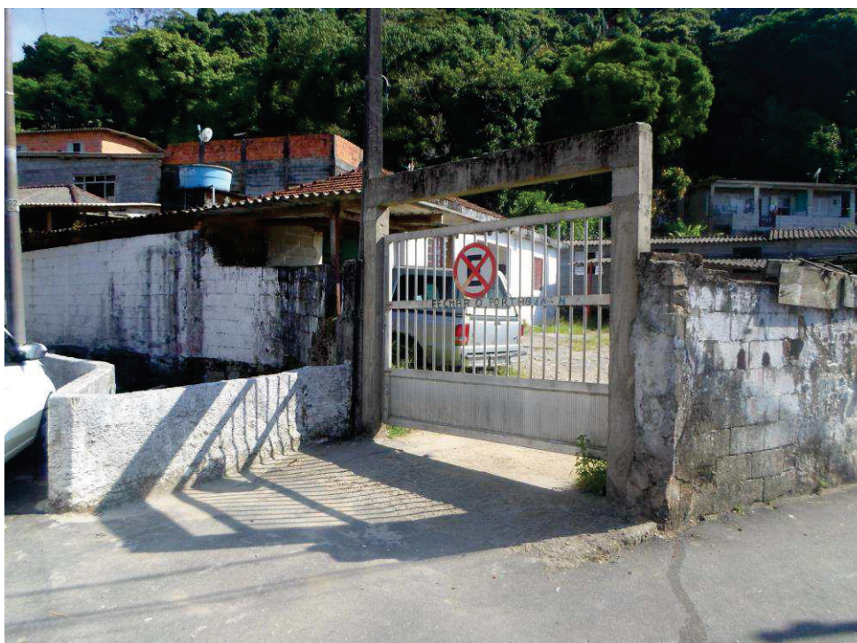
Na imagem acima, tem-se uma demonstração da fachada do imóvel, onde nota-se as suas características de acesso e topografia.
