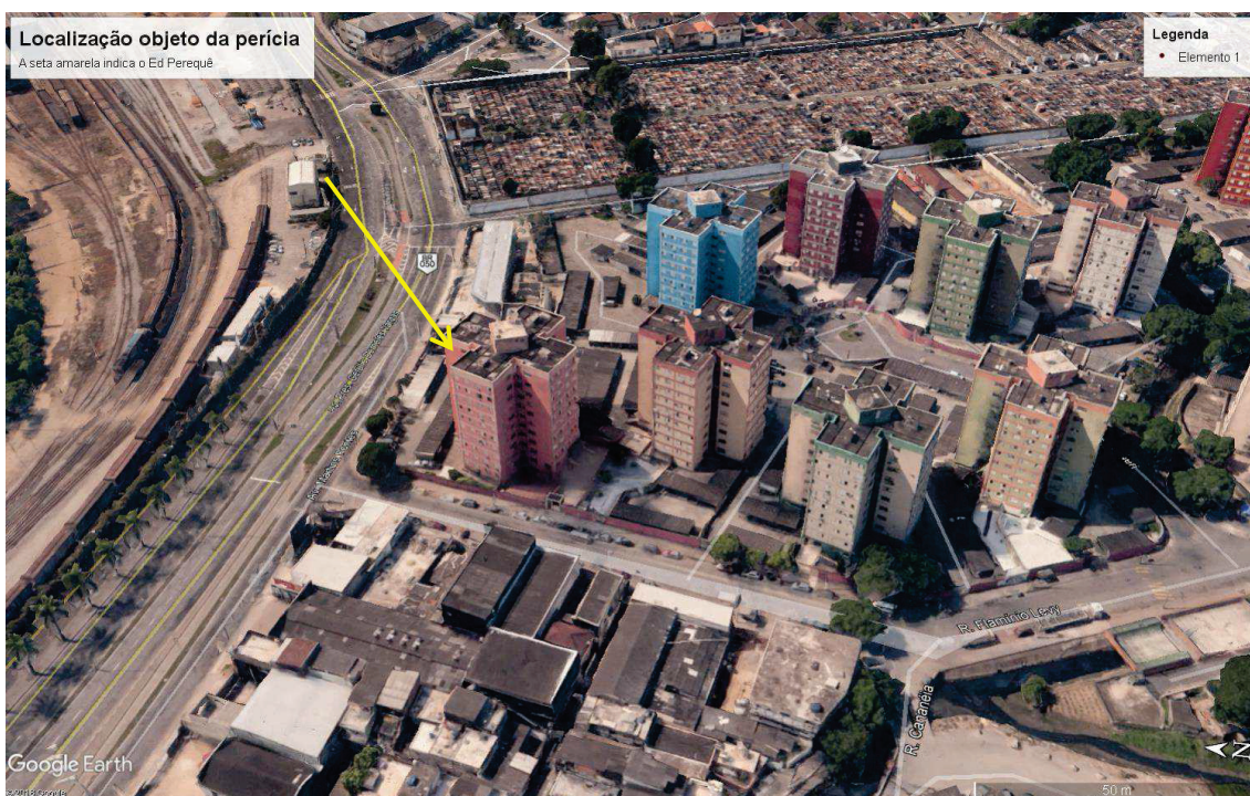
Figura 2: Localização do Edifício Perequê.
