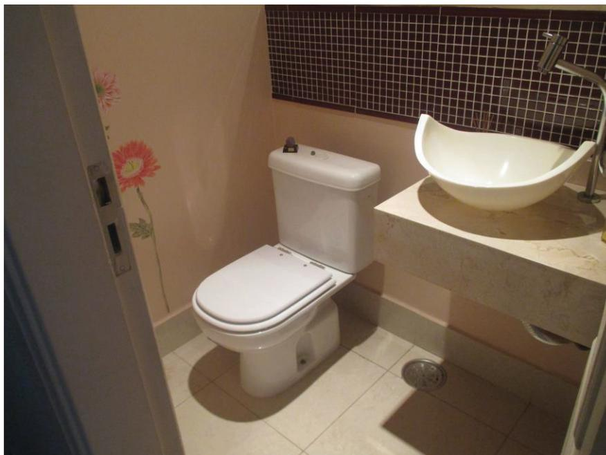
Acima e abaixo, observa-se o banheiro com piso em cerâmica, paredes revestida com massa fina pintada com detalhe em pastilha, teto revestido com massa fina pintada e porta de madeira.
