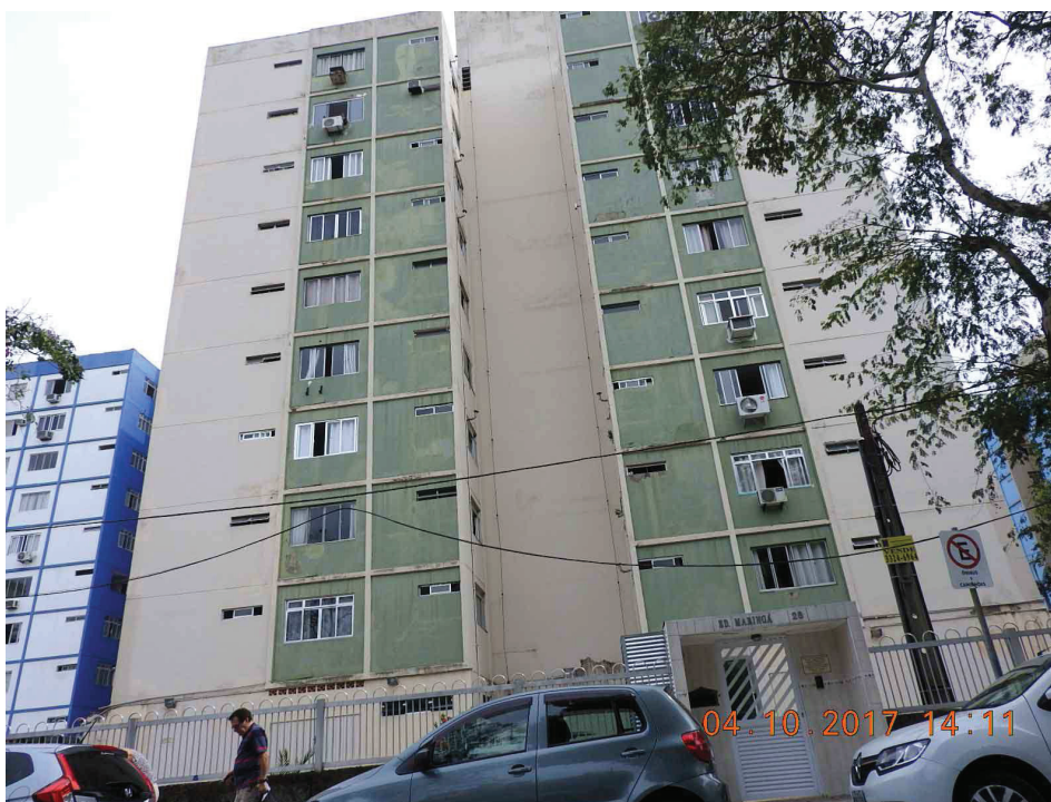
Foto 04 – Vista frontal do Edifício Maringá.
