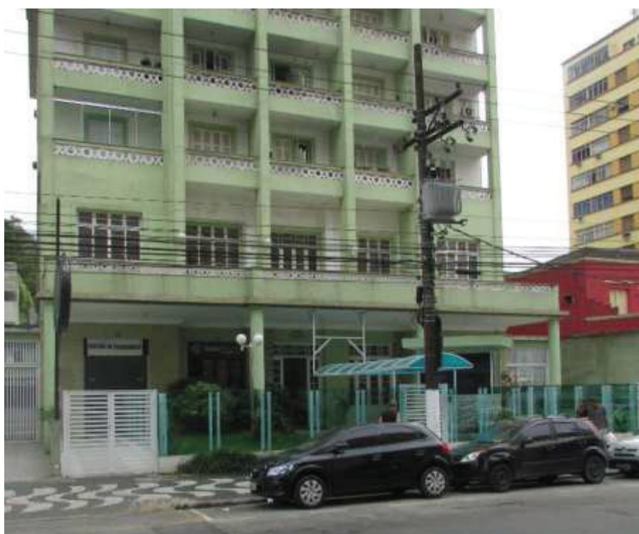
Acima, temos uma tomada da entrada do “Edifício Paranapuã” em questão.
