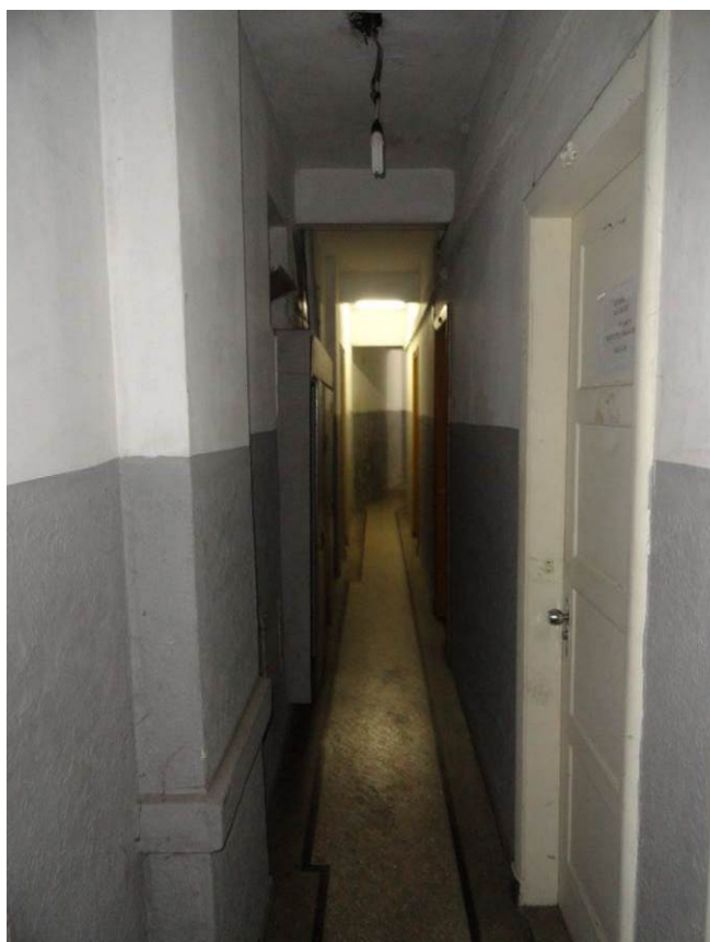
VISTA DO CORREDOR DE ACESSO A SALA N° 29 (PADRÃO CONSTRUTIVO).
