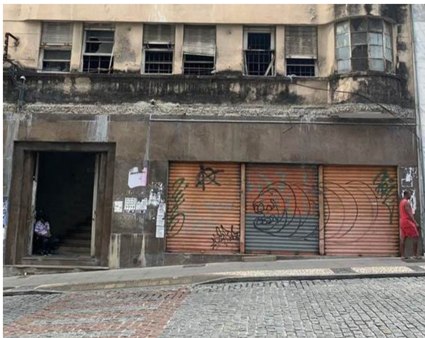
VISTA DA ENTRADA DO EDIFÍCIO.
