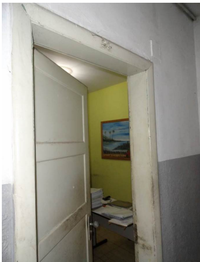
VISTA DA PORTA DE ENTRADA DA SALA N° 29 (PADRÃO CONSTRUTIVO).
