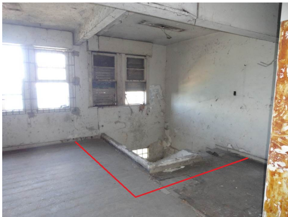
VISTA DA SALA AVALIANDA (DESCARACTERIZADA).
