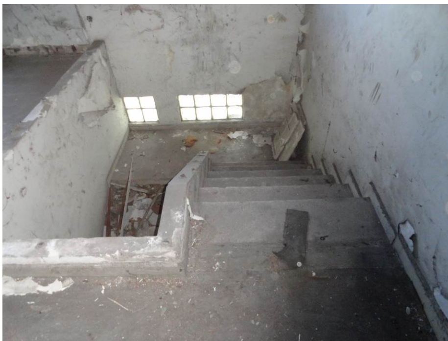
VISTA DA SALA AVALIANDA (DESCARACTERIZADA).
